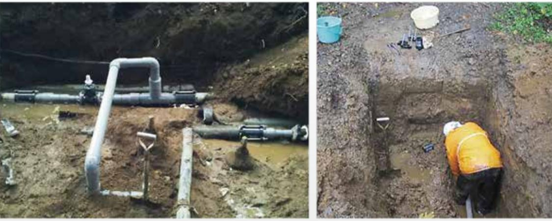
昨年6月1号送水ポンプが突然故障するトラブルが発生しました。断水を極力防ぐべく徹夜での作業となりましたがポンプは直らず、現在の送水方法を断念、2号貯水槽から高低差を利用送水するバイパス工事を敢行、試行錯誤の上無事完了しました。この送水方法なら、節電対策と、ポンプの負担軽減にも効果が見込まれます。現在、安定した供給を続けておりますが、漏水につきましても迅速な対応を心掛け、引き続き安定、安心の業務を行って参ります。
